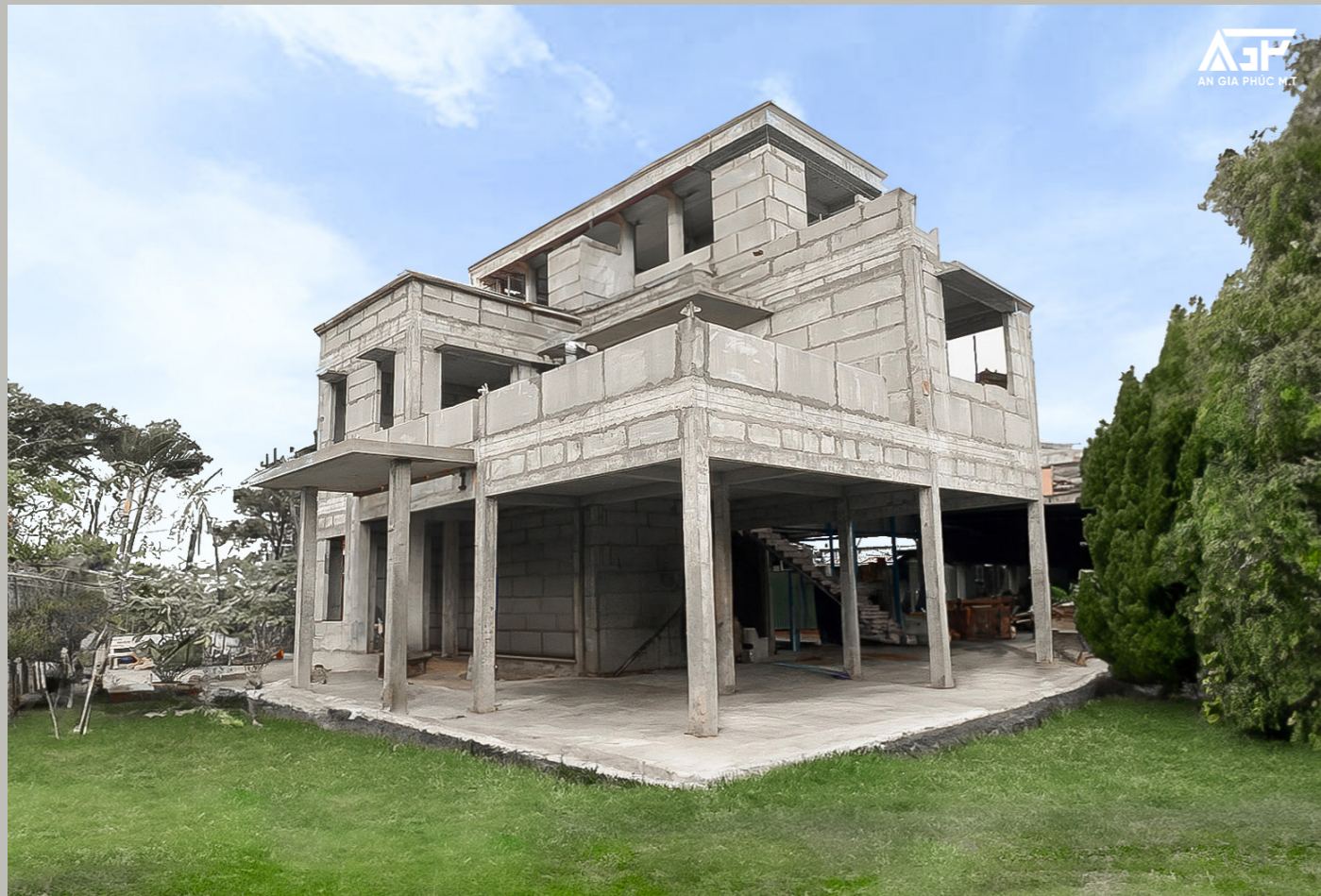
Phần thô văn phòng Công ty TNHH An Gia Phúc M.T ngụ tại tỉnh Vĩnh Long được xây dựng bằng vật liệu bê tông bọt khí do chính Công ty sản xuất.
