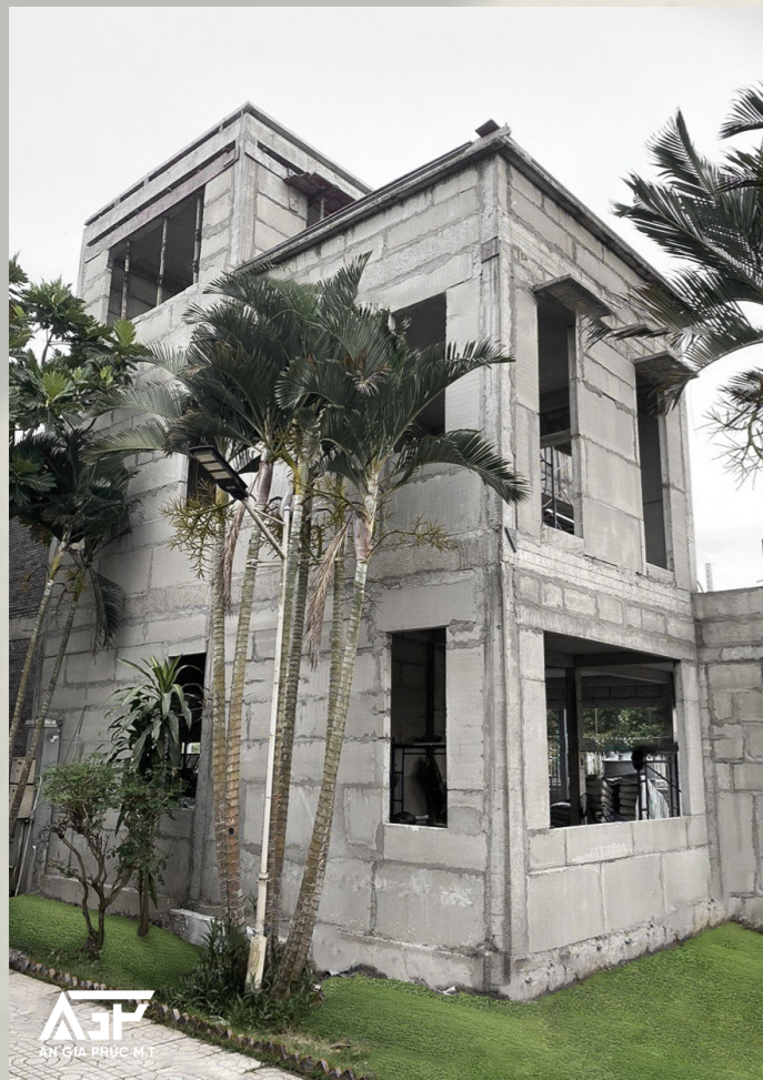
Phần thô văn phòng Công ty TNHH An Gia Phúc M.T ngụ tại tỉnh Vĩnh Long được xây dựng bằng vật liệu bê tông bọt khí do chính Công ty sản xuất.
