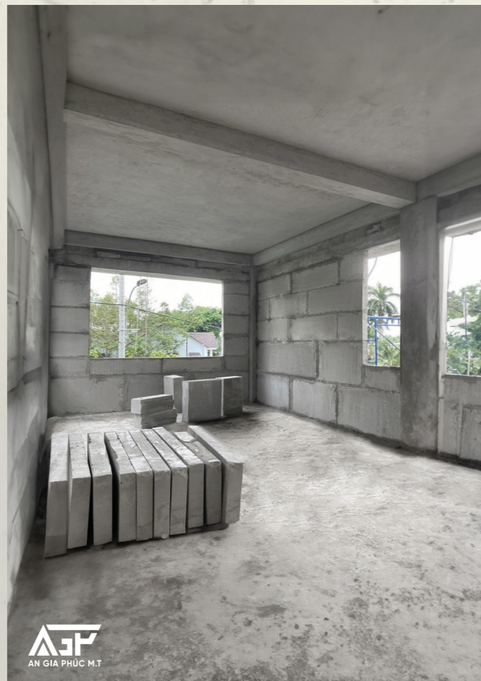
Phần thô văn phòng Công ty TNHH An Gia Phúc M.T ngụ tại tỉnh Vĩnh Long được xây dựng bằng vật liệu bê tông bọt khí do chính Công ty sản xuất.
